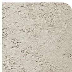
Fassade mit Betonputz
